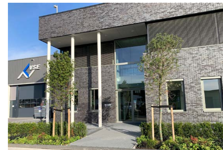
Het innovatieve pand van VSE te Schoonhoven is voorzien van alle hedendaagse duurzame technieken.
